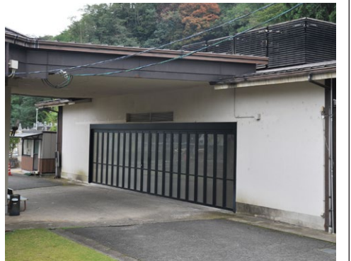
建設から45年が経過し老朽化が進む桜井市火葬場。
