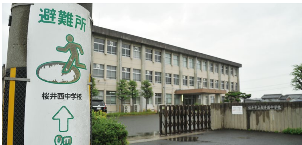
指定緊急避難所として優先的に環境改善が検討されている13施設
